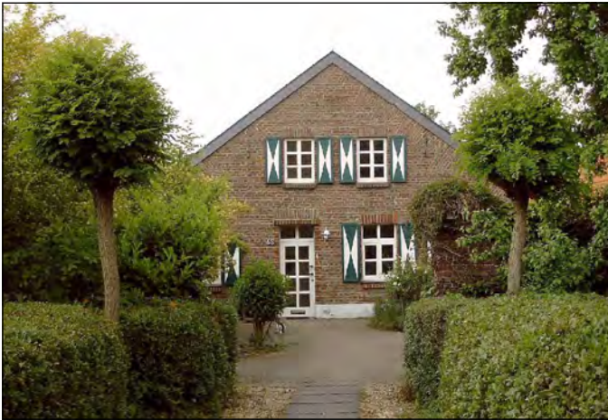
Eine kleine Hofanlage, die außen recht behutsam saniert wurde. Die typische Farbgestaltung wurde übernommen bzw. wieder hergestellt. Auch blieben die Proportionen der Öffnungen zum Gesamtgebäude erhalten. Der Vorgarten folgt mit seiner Symmetrie barocken Gestaltungsmustern.
