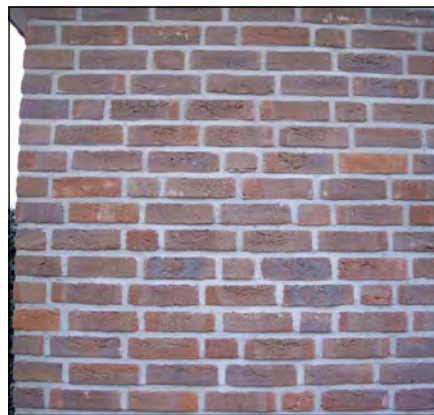
Wilder Verband an einem Neubau
