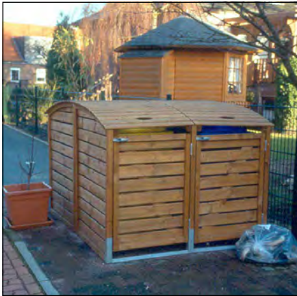
Die privaten Mülltonnen werden oft im unmittelbaren Grenzbereich zur Straße aufgestellt. Diese Holzverkleidung passt sich ins Straßenbild ein und beschattet den Müll.
