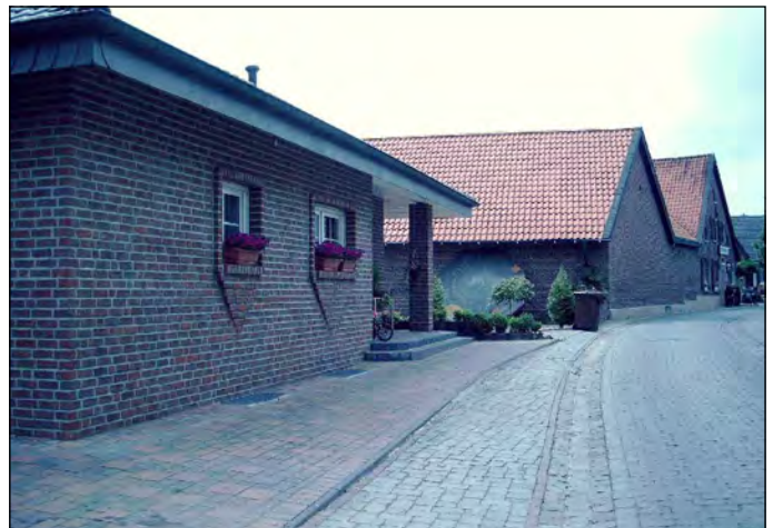
Der Neubau in der Dorfstraße hat seine Chance nicht genutzt und rotes Betonsteinpflaster zwischen Hauswand und Straße gelegt. Begrünung wurde auf wenige Kübel beschränkt.
