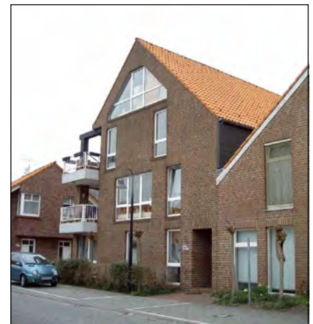
Dieser Neubau überragt die umgebende ein- bis zweigeschossige Bebauung im Ortskern von Born.
