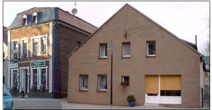
Heute haben die Gebäude rechts und links der Gaststätte Kehren ihr Gesicht hinter einer Riemchenhaut versteckt. Der einladende Eingang ist durch ein Toilettenfenster ersetzt worden.
