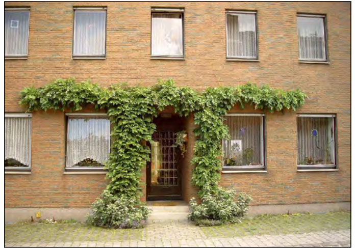
Blauregen als Fassadenbegrünung
