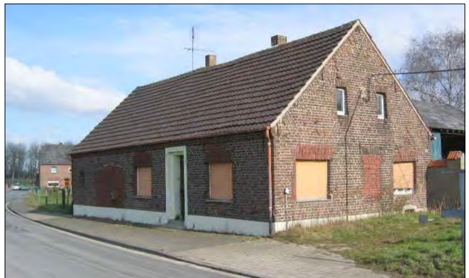
Zum Abriss freigegeben: Genroher Straße 30
