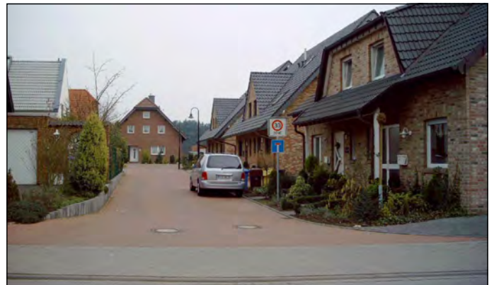
Rot sollte den Ziegelsteinen der Gebäude vorbehalten bleiben
