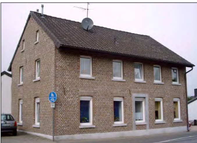
Diese ehemalige Gaststätte an der Boisheimer Straße (vermutlich Anfang 20. Jh.) entspricht dem niederrheinischen Bautypus. Leider wurde die Eingangstüre der Mittelachse verlegt (wo bitte ist der Eingang?) und die sprossenlosen Fenster geben dem Haus eine nüchterne Note.
