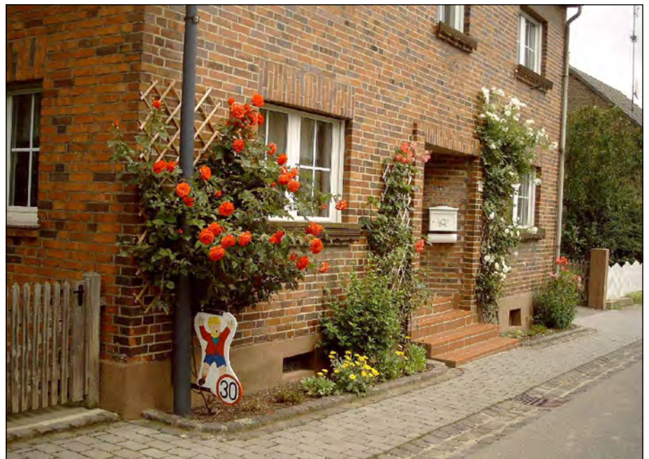
Vorbild Eggersheim: Für diese üppigen Kletterrosen ist ein schmales Beet mit Naturstein-einfassung ausreichend. Fassaden werden erheblich aufgewertet und würden in Born zur Verschönerung des Kirchplatzes beitragen.
