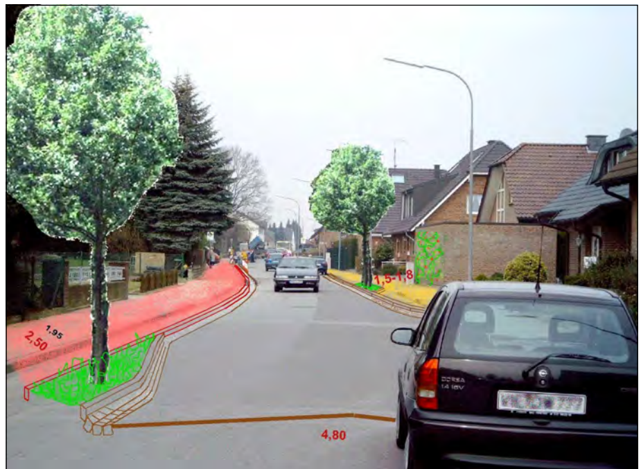
Fotomontage An der Kreuzstraße. Fahrbahnbreite 4,75 m, Gehweg mind. 1,50 m und Rad-/Gehweg 2,50 m, einzelne Baumbeete
