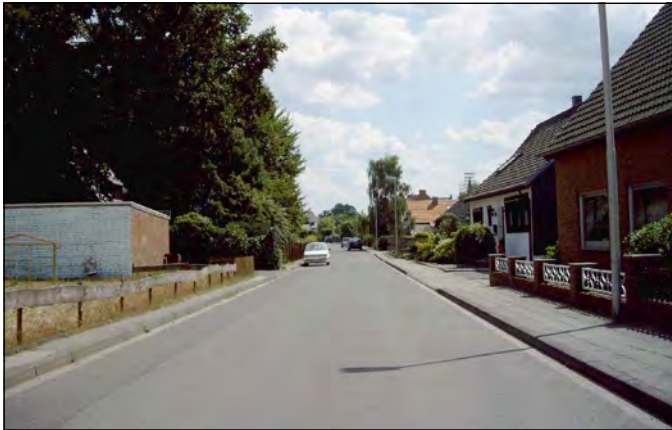
Autogerecht: Borner Feld, der linke Gehweg ist nutzlos
