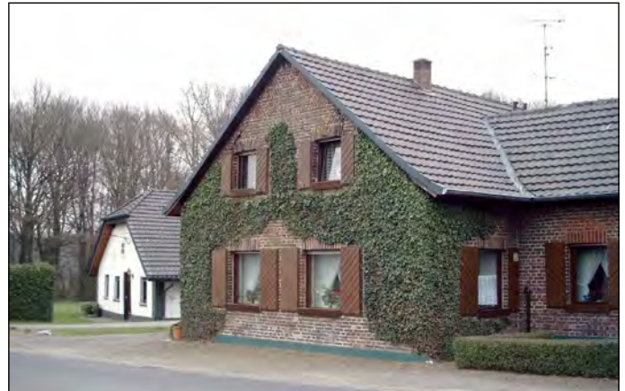
Heute sind die Fenster verbreitert und die hellen Sprossenfenster durch einflügelige dunkle Fenster ersetzt worden. Farblich beißt sich der blaugrüne kleine Sockel mit dem satten warmen Grün des Efeus. Die braunen Schlagläden heben sich zu wenig von dem dunklen Backstein der Fassade ab.
