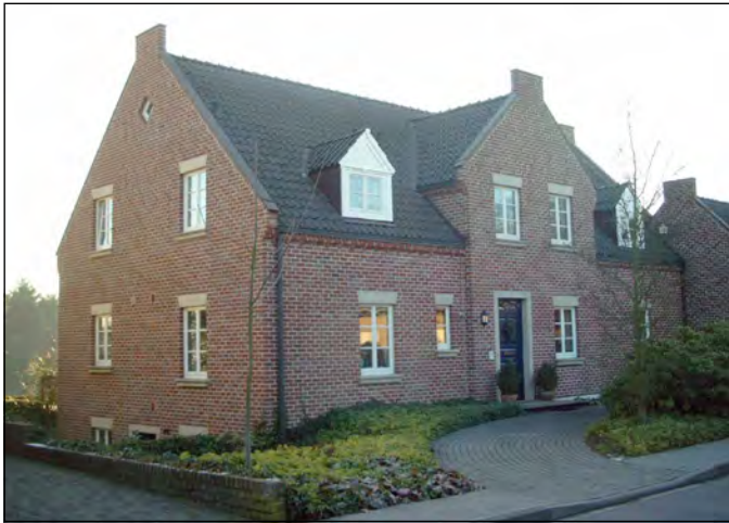
Historisierender Neubau: Inkonsequent bei der Ausführung mit einem Läuferverband im Verblendmauerwerk. Die Mauerscheibe, die am Giebel über den First hinausragt, erinnert eher an einen stilisierten gotischen Treppengiebel des Münsterlandes.
