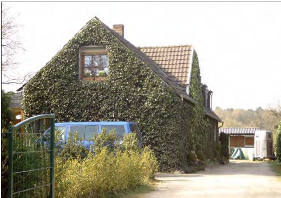
Fassadenbegrünung schützt vor Witterungseinflüssen & wertet das Gebäude optisch auf
