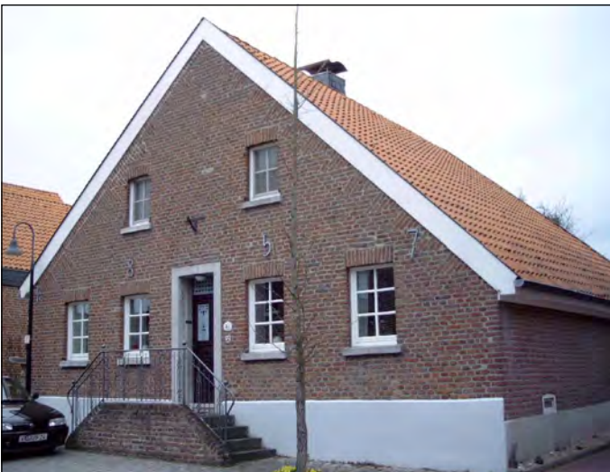
Dieses einfache Haus von 1857 wurde denkmalgerecht saniert. Das weiße Ortgangbrett und der helle Sockel geben dem Gebäude eine gewisse Leichtigkeit.
