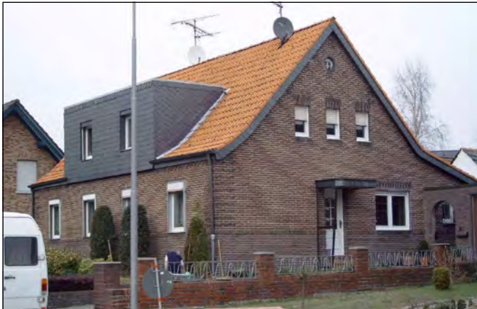
Ein Doppelhaus An der Kreuzstraße aus den 1920er Jahren. Die dunkle große Gaube dominiert das kleine Gebäude zu stark. Die Feinheiten im Mauerwerk, z.B. die Eckausbildungen, werden dadurch kaum wahrgenommen. Schiefer oder Kunstschiefer ist für diese Häuser ein fremdes Material.
