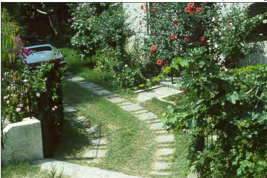
Zufahrt: Nur die Fahrspur ist befestigt
