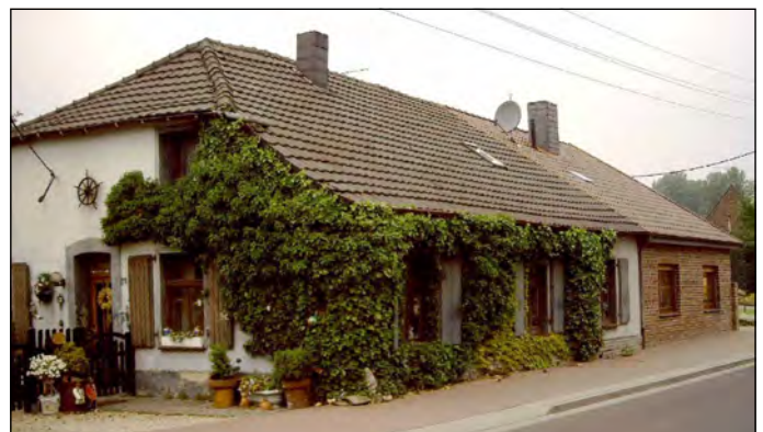
Diese Häuser stehen auch entlang der Genroher Straße. Der weiße Putz fällt aus der Reihe. Das Krüppelwalmdach lässt vermuten, dass das Haus noch aus dem 19. Jh. stammt, erst später wurde das Satteldach bevorzugt, um eine zusätzliche Schlafstube im Giebel unterzubringen. Das rechte Gebäude könnte der Stall gewesen sein oder erst später angebaut worden sein. Die Fenster wurden nachträglich verbreitert.
