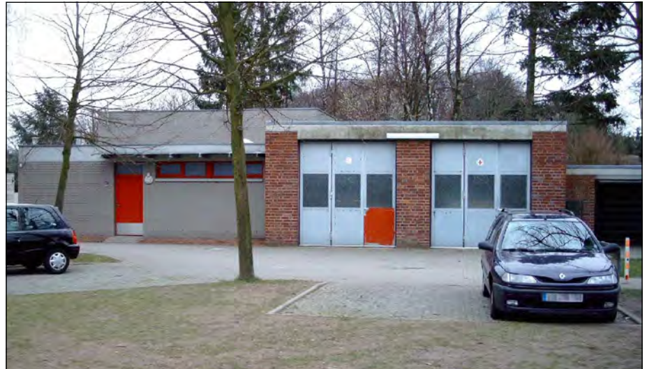
Feuerwehr-Gerätehaus am Hustenfeld
