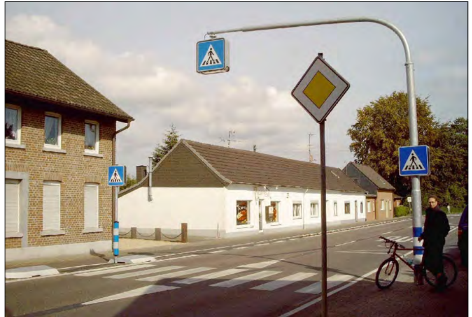
Bestand Boisheimer Straße nach dem Umbau durch den LandesBetriebStraßen NRW
